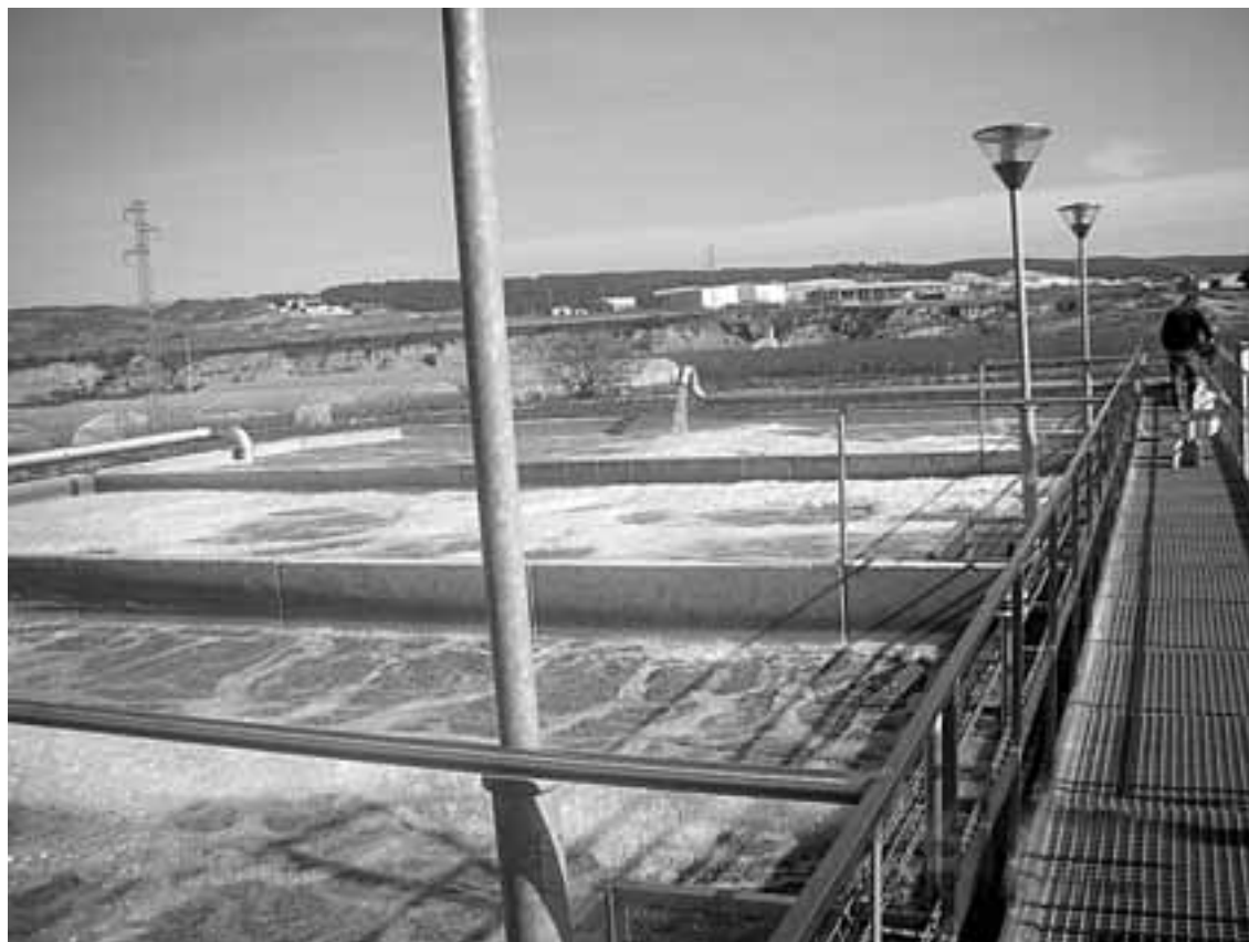
Depuradora construida por Proyectos Navarra para Boundelle en Milagro.
