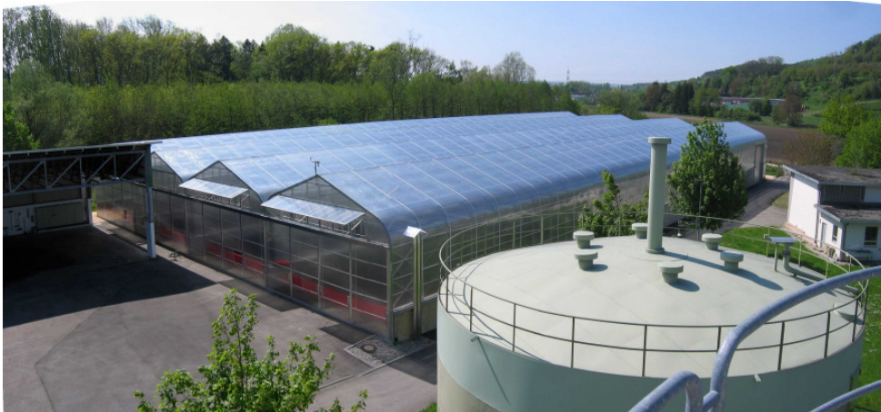
Cuadro 6: Planta de secado solar de lodos de depuración de Stockach, Alemania
