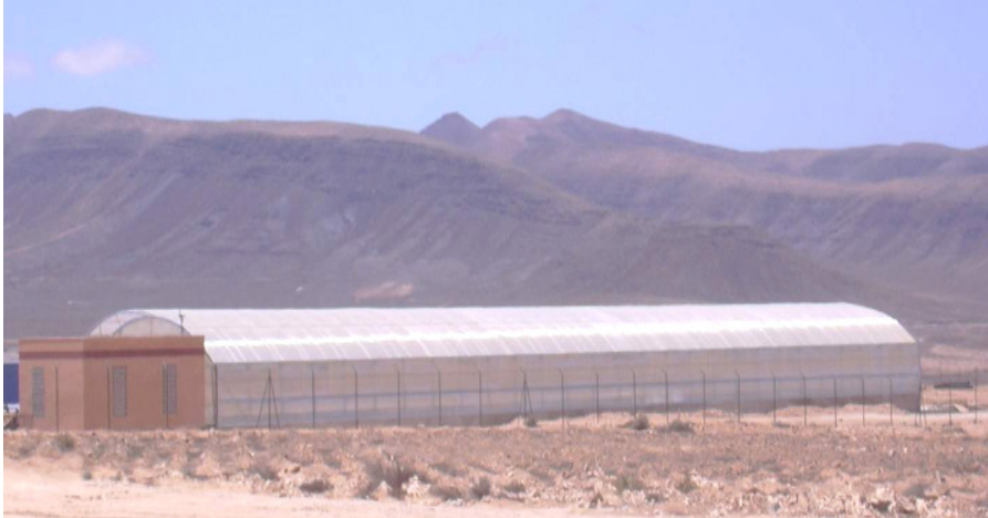
Cuadro 5: Planta de secado solar de lodos de depuración de Antigua - Fuerteventura
