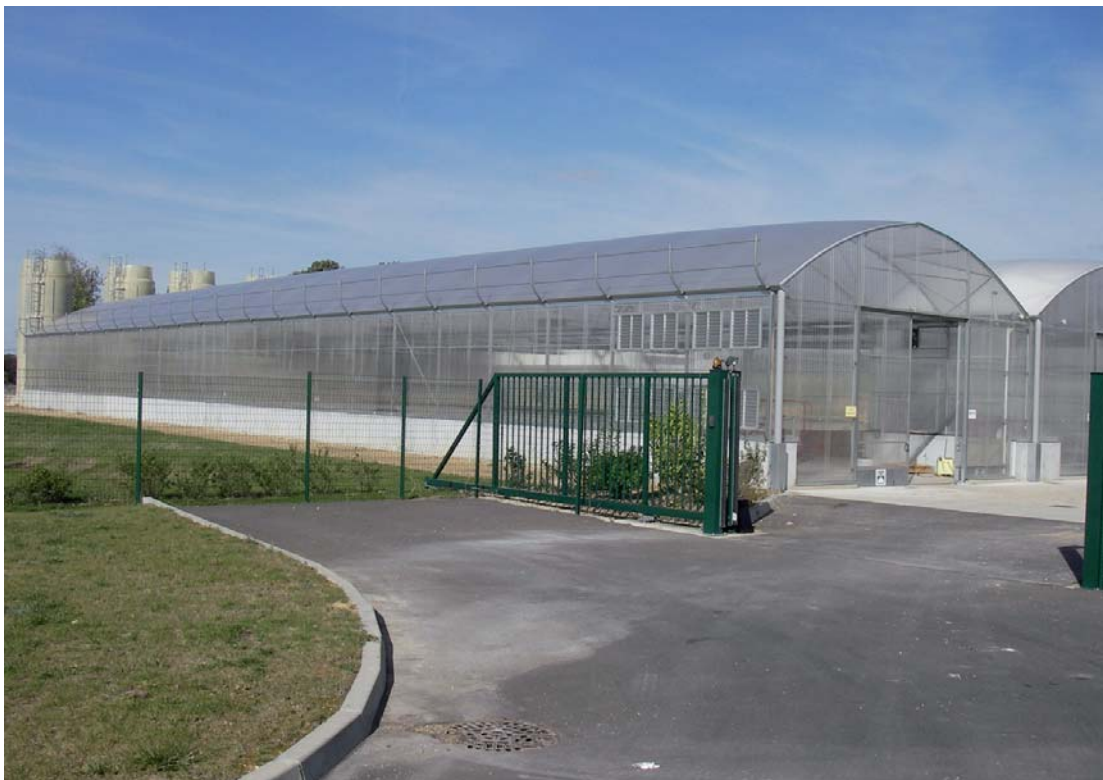
Almacén de secado solar de Naveil con dos cámaras de secado
