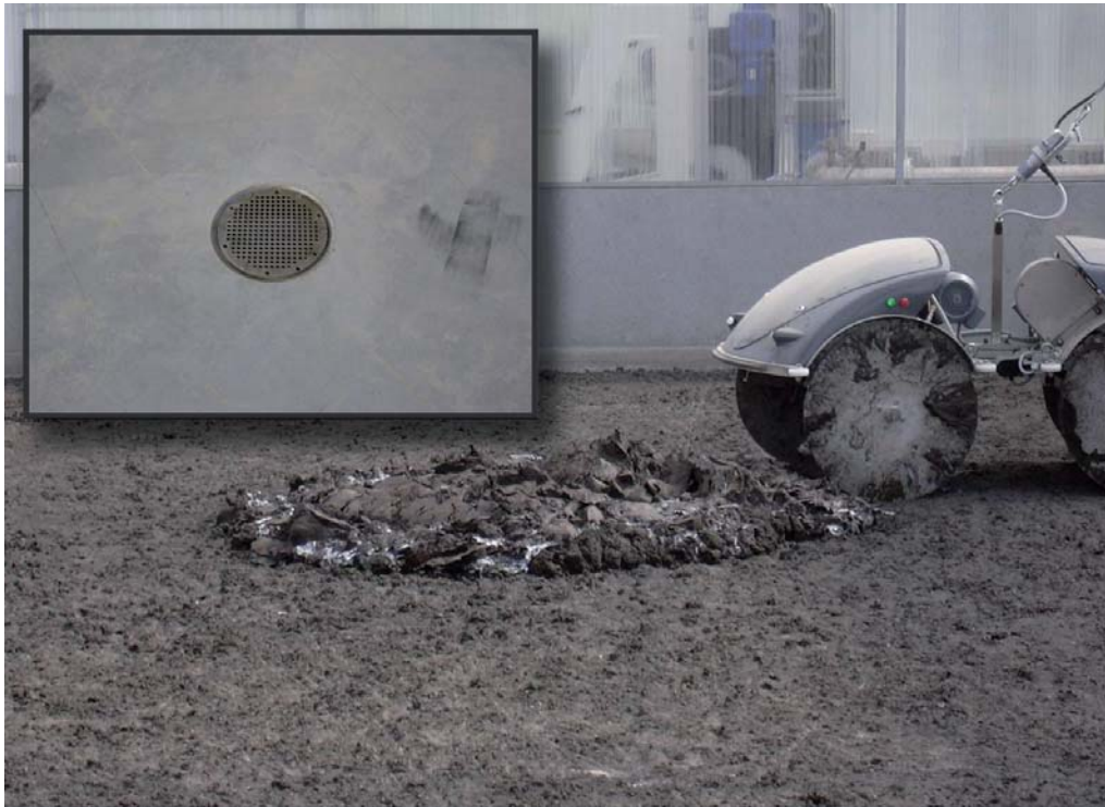
Aporte de lodos a través del géiser de lodo (apertura de alimentación por la solera)
