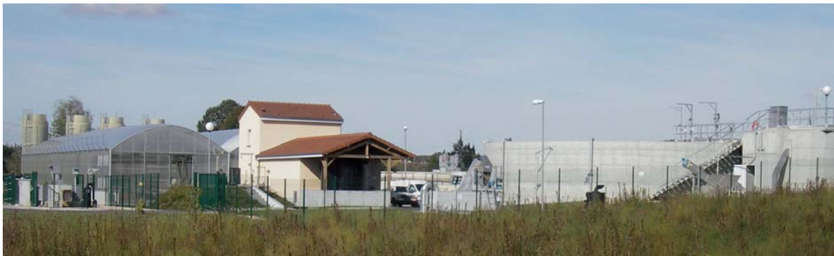
Depuradora de Naveil (Vendôme) con instalación de secado solar
